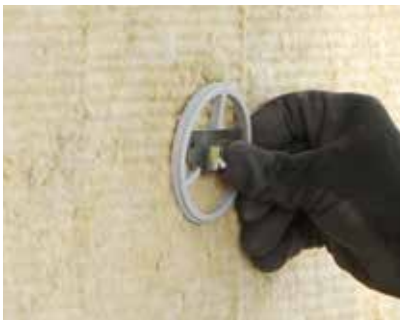
Finngard Villakiinnike painetaan heilurihaan. Samalla heilurihaka painetaan alas, jolloin se lukittuu 45° kulmaan.
