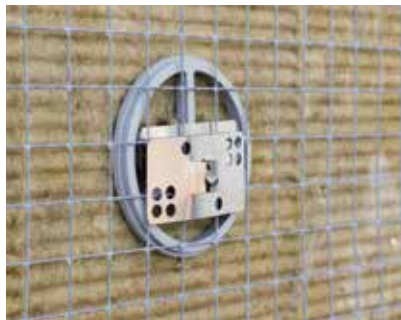
Finngard Teräsverkko asennetaan eristyskerroksen päälle ja lukitaan heilurihaan päähän painettavalla lukituslevyllä.
