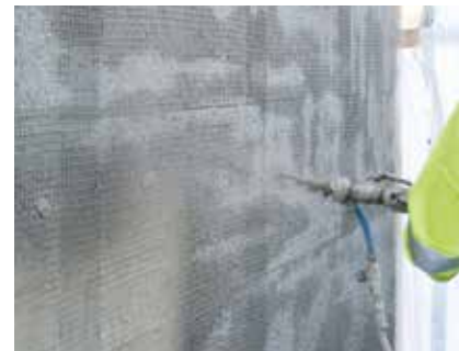
Pohjarappaus pyritään ajamaan mahdollisimman täyteen. Menekki n. 15 kg/m 2
