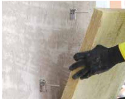
Eriste painetaan Finngard Heilurihaan läpi.
